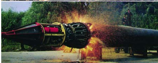
Комплекс "Північ" для контактного зварювання труб магістральних трубопроводів
