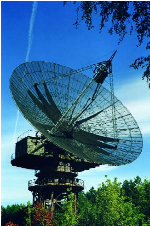
Повноповоротна параболічна антена діаметром 25 м
