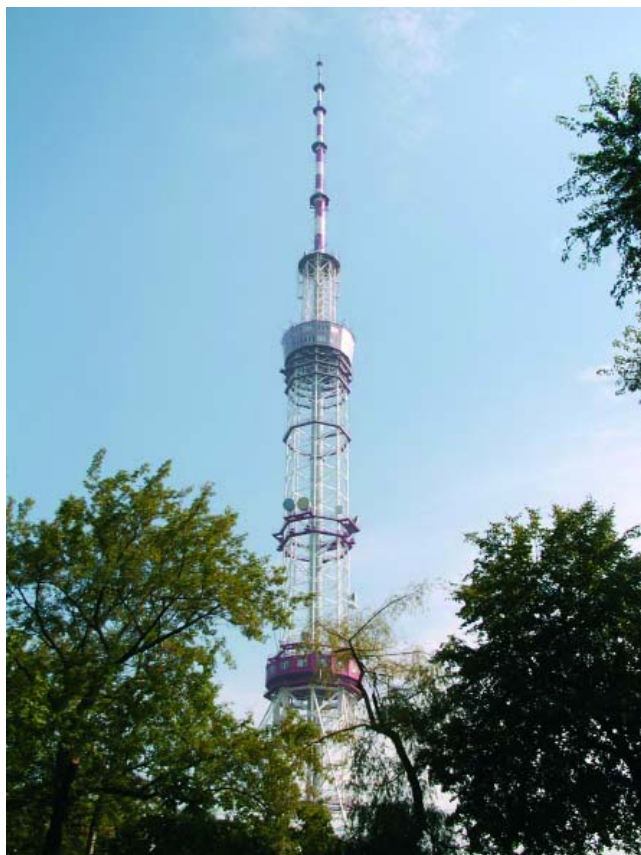
Телевізійна вежа, споруджена за технологією Інституту електрозварювання ім. Є.О. Патона АН УРСР у 1973 р.
