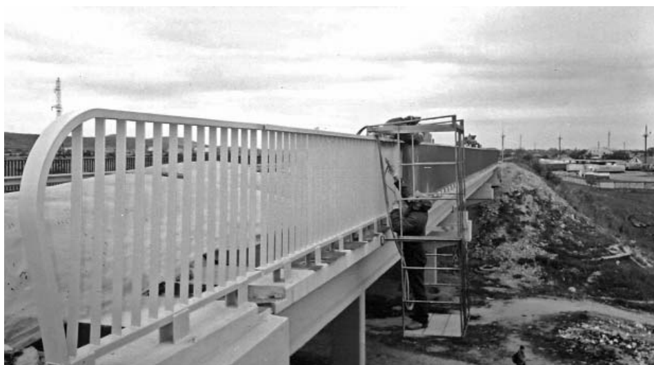
Нанесення антикорозійного покриття на металеві елементи мостових конструкцій за технологіями, розробленими у ФМІ
