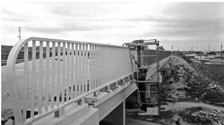
Нанесение антикоррозийного покрытия на металлические элементы мостовых конструкций по технологиям, разработанным в ФМИ
