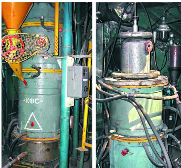
Рис. 7. Устройство управления механизмами встряхивания электродов электрофильтров
