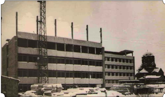
Будівництво корпусів Інституту проблем міцності АН УРСР.
