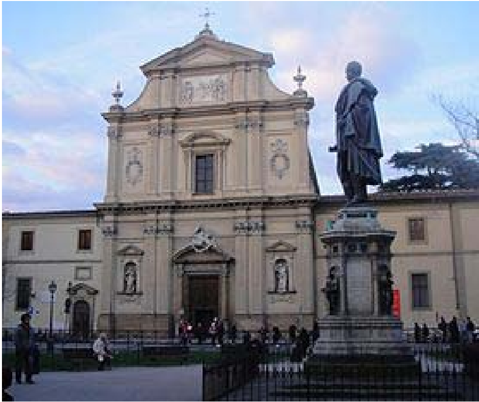
Рис. 4.31. Фасад церкви Сан Марко
