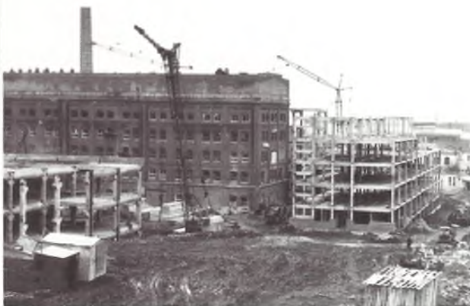
Будівництво шоколадної фабрики «Україна». 1973 р.
