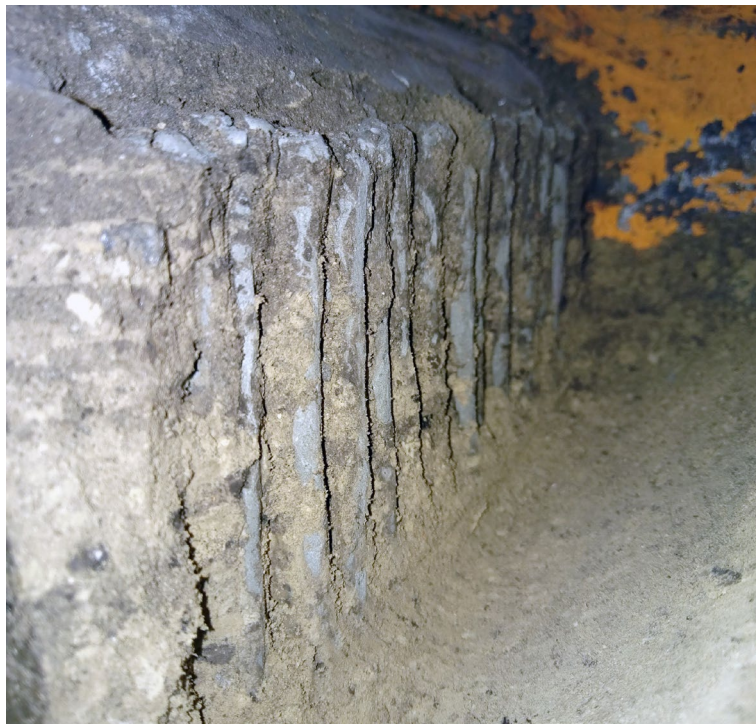
Рис. 3. Модель схилу з ґрунтоцементними паллями після обертання на центрифугі. Передня частина ґрунту знята для обстеження стану паль
