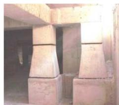
Рис.1. В этом доме сейсмоизолирующие опоры располагаются в подвальном помещении, используемом для автостоянок.
