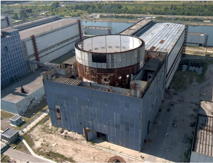
Рис. 15.5. Фото ХАЕС-3 (2010 р.). Будівельна готовність складає 75%.
