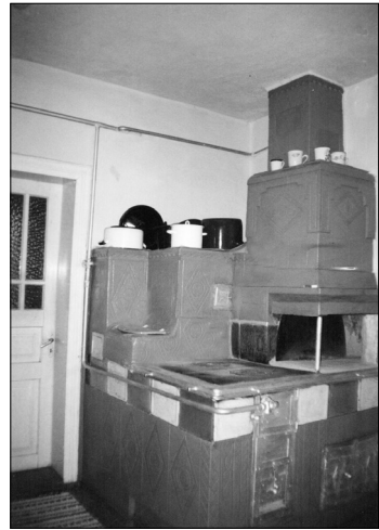
Опалювальний комплекс, обштукатурений і пофарбований
