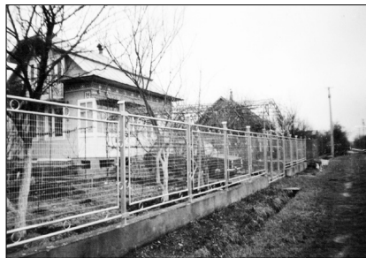
Огорожа з використанням сітки і зварних конструкцій із труб
