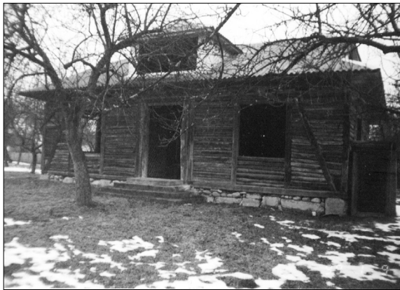
Приклад закидки стін кругляком
