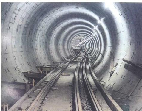
Рис. 7.7. Общий вид тоннеля метро глубокого заложения
