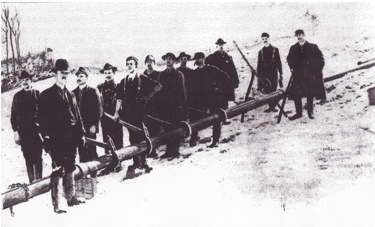
Рис. 8.1. Строительство первого в мире трубопровода большой длины (США)
