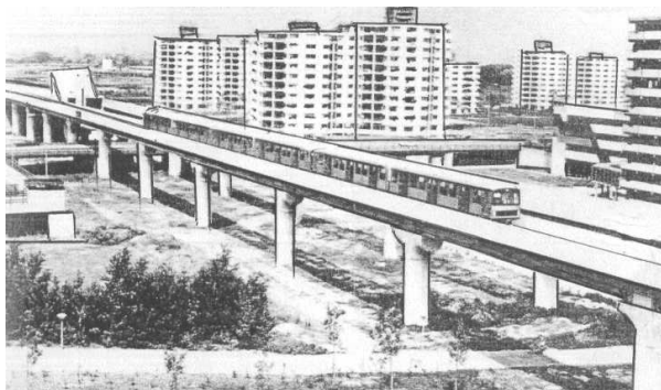
Рис. 7.2. Надземная прокладка метро на эстакадах (Копенгаген)
