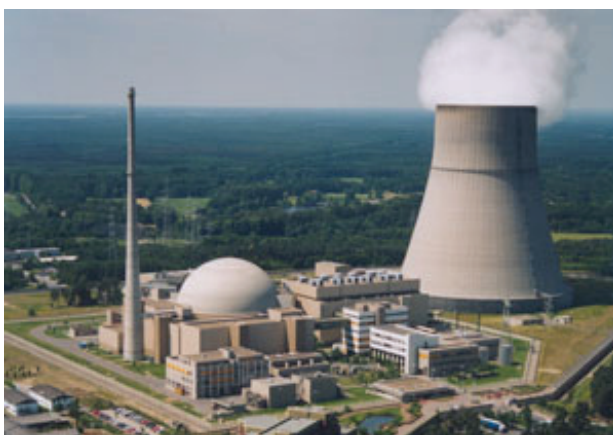
Рис. 2.7. Панорама атомной электростанции (Германия)
