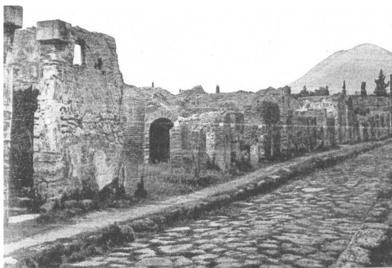
Рис. 1.10. Одна из улиц Помпеи, которая откопана
