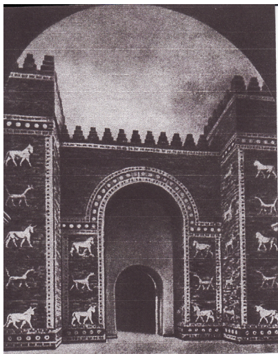
Рис. 4.3. Ворота храма богини Иштар в Вавилоне, сооруженные около 570 г. до н.э. из глазурованных кирпичей, скрепленных асфальтом
