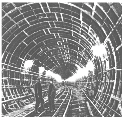
Рис. 7.21. Отделка тоннеля метро чугунными тубингами
