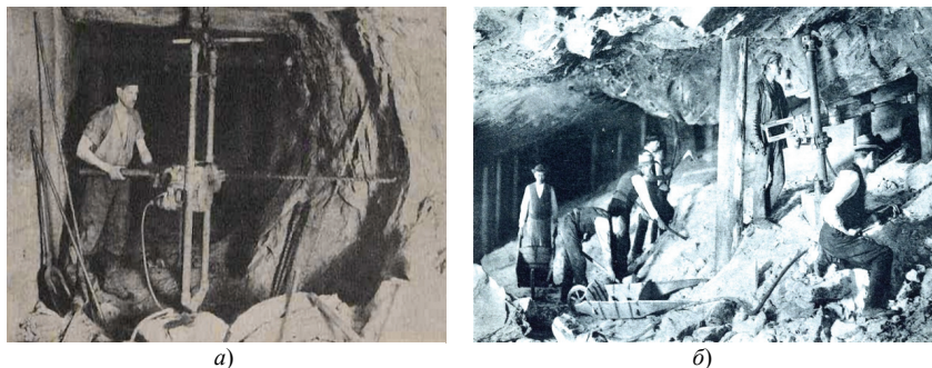
Рис. 2.21. Бурение шпуров в камере (а) и погрузка взорванной соли (б) (Величка, Польша)
