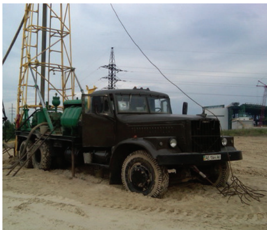
Рис. 5.3. Бурение скважин передвижной установкой УРБ-3АМ
