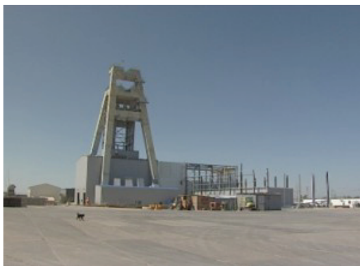
Рис. 4.5. Строительство вертикального ствола калийного рудника
