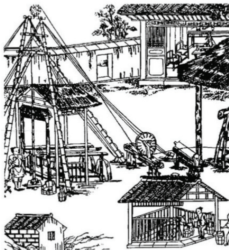
Рис. 2.9. Бурение скважин в Китае для добычи рассолов (1-е тыс. до н. э.)
