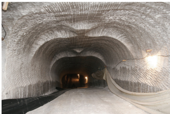
Рис. 3.15. Форма выработок, пройденных в каменной соли комбайном «Урал»
