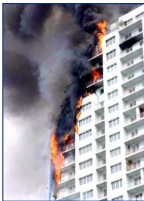
Рис. 2.22. Пожежа будинку з SIP панелей
