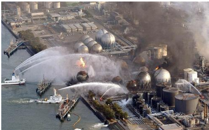
Ликвидация последствий аварии на АЭС «Фукусима-1» Фото: www.compulenta.computerra.ru
