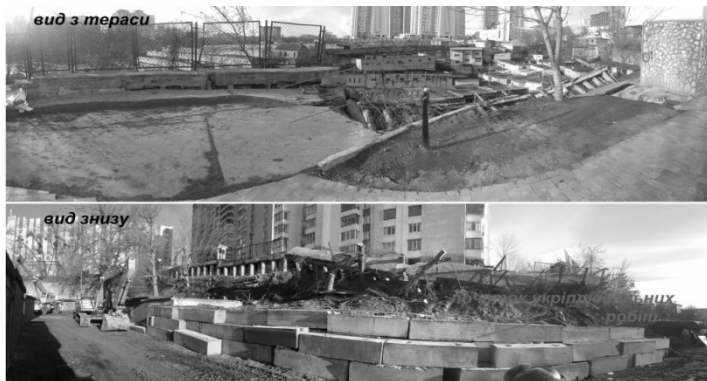
Рис. 4. Характер руйнування підпірної стінки
