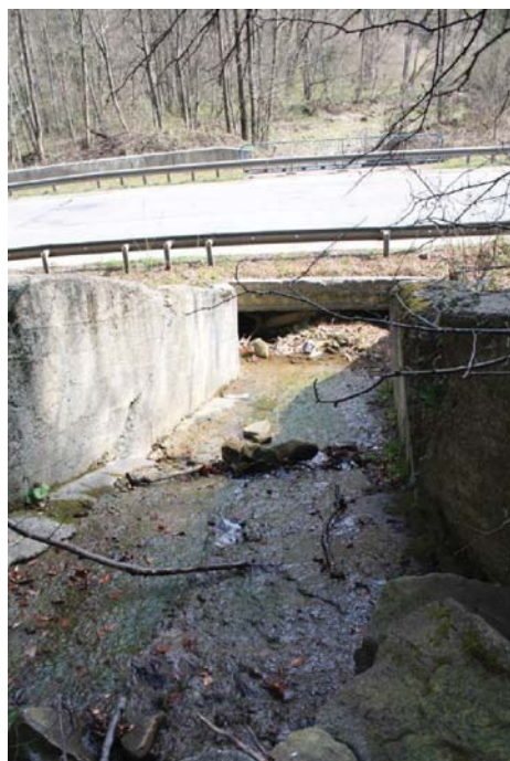
Рис. 2.11. Конус виносу ярково-балкового селевого потоку у басейні річки Орява (квітень 2014), що систематично виходить на трасу Київ-Чоп
