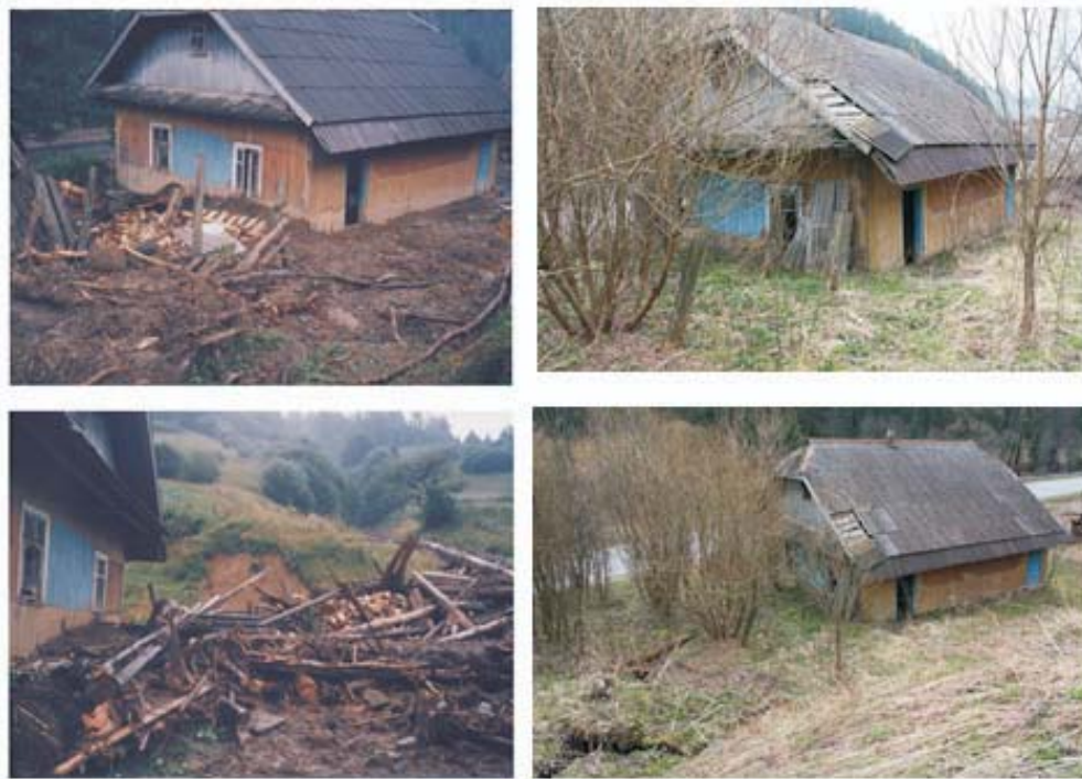
Рис. 2.14. Руйнування житлового будинку, спричинені сходженням селевого потоку, зумовленого екстремальними опадами 18.08.2004 р. у с. Козева Сколівського району (зліва) та результат процесів 10-річного самовідновлення рослинного покриття, квітень, 2015 р. (справа)
