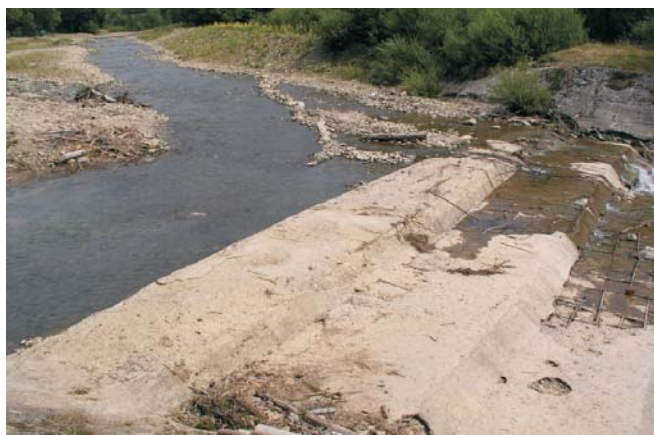
Рис. 2.23. Водозабір з річки Бутівля для потреб форельного господарства в с. Коростів (обсяги забору – 49 тис. м 3 води за рік)
