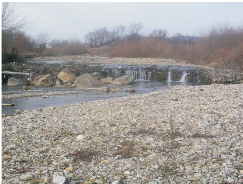
Рис. 4.11. Габіони у руслі Яблуньки, закладені для зменшення інтенсивності врізання русла, січень 2007 р.
