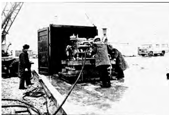
Рис. 1. Загрузка дизеля на открытой площадке (Находка, 1983 г.)
