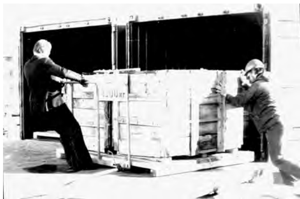
Рис. 2. Загрузка ящичного груза в контейнер (Находка, 1985 г.)
