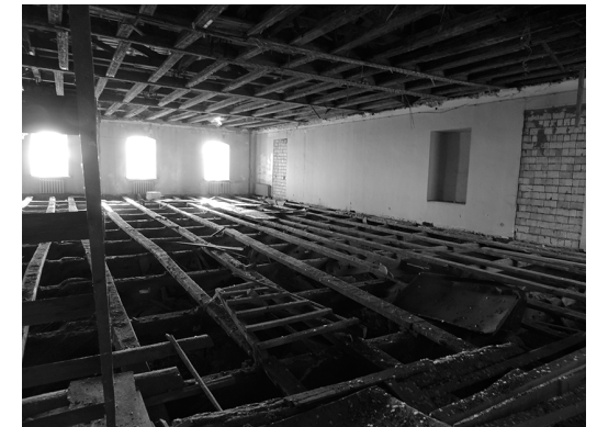
Іл. 3. Інтер'єр другого поверху Кухні Трапезної палати (Трапезна) – повністю розібрано міжповерхові та горищне перекриття, конструкції підлоги та стелі
