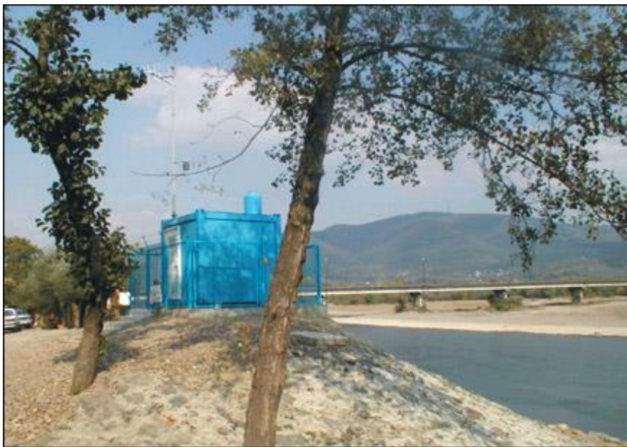
Рис. 9.6. Комплексна гідрологічна станція системи АІВС «Тиса» на р. Тиса біля с. Крива Хустського району Закарпатська область (БУВР Тиси)
