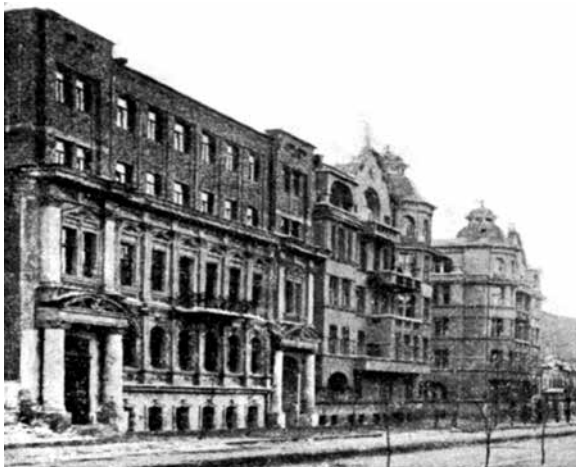
Будівля Українського державного інституту удосконалення лікарів (м. Харків, вул. Артема, 8; 30-і роки XX століття)
