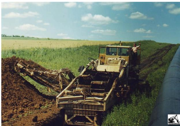
**Рис. 7.7. Разработка траншеи роторным траншейным экскаватором в нормальных условиях**
