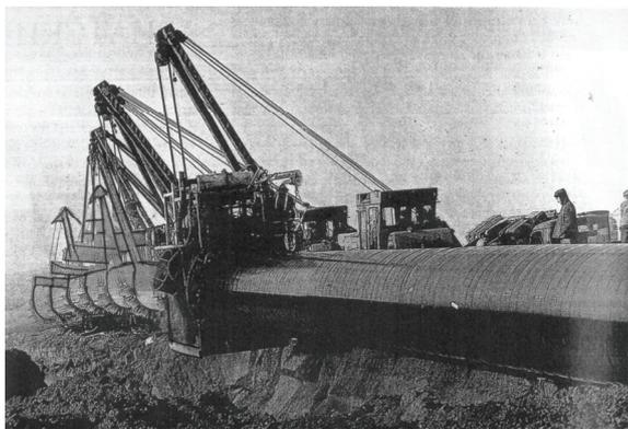
**Рис. 9.2. Изоляционно-укладочная колонна на строительстве магистрального трубопровода**
