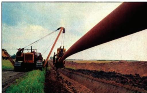
Рис. 9.5. Укладка трубопровода в траншею
