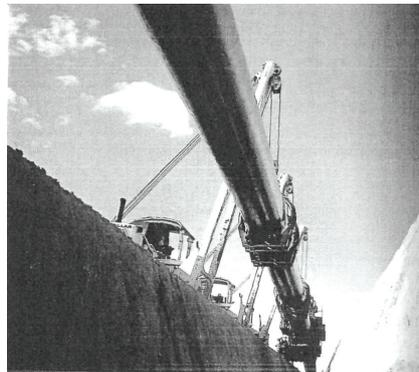
**Рис. 9.10.** Удержание изолированного трубопровода троллейными подвесками при укладке в траншею
