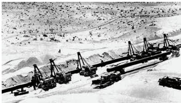
Рис. 1.36. Строительство участка газопровода САЦ в песках пустыни Каракум
