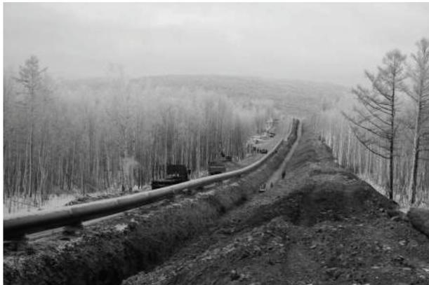
Рис. 2.4. Строительство линейной части газопровода
