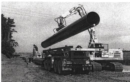
Рис. 6.6. Разгрузка изолированных труб электромагнитными захватами
