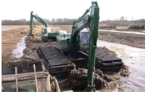
**Рис. 7.17. Разработка траншеи болотным экскаватором**
