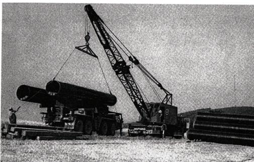
**Рис. 6.3.** Разгрузка труб с помощью крана и траверсы
