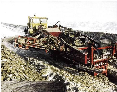
**Рис. 7.10. Разработка траншей роторным траншейным экскаватором в мерзлых грунтах**
