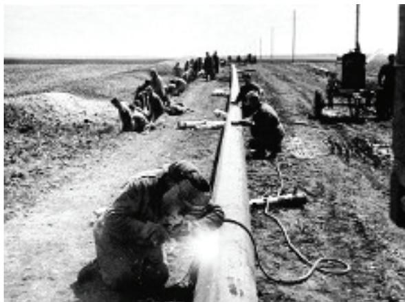
**Рис. 1.32. На строительстве газопровода Саратов – Москва**
