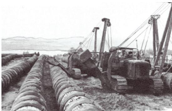
**Рис. 10.9. Подготовленные секции трубопровода для укладки их в подводную траншею**
