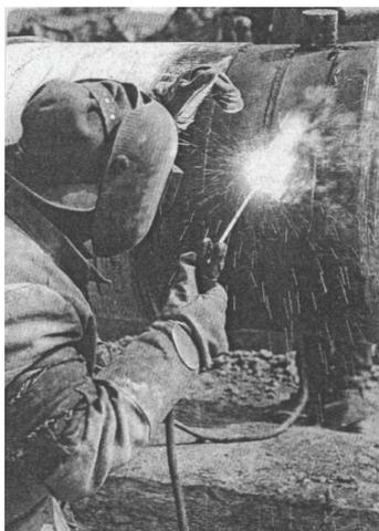
**Рис. 8.14. Сварка корневого шва**
