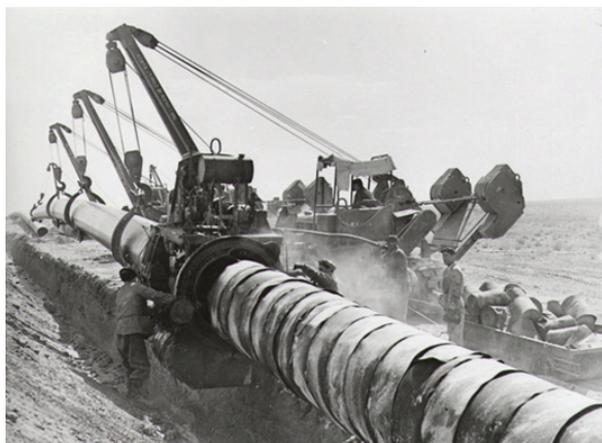
**Рис. 1.35.** Изоляционно-укладочные работы на строительстве газопровода Средняя Азия – Центр
