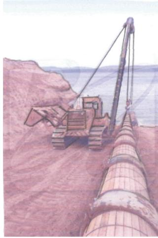
**Рис. 10.10.** Подготовленная плеть к протаскиванию в створе подводной траншеи
