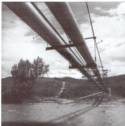
**Рис. 10.19. Общий вид висячего перехода трубопровода:**
