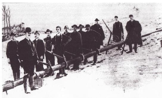
Рис. 1.15. Строительство первого в США магистрального нефтепровода
