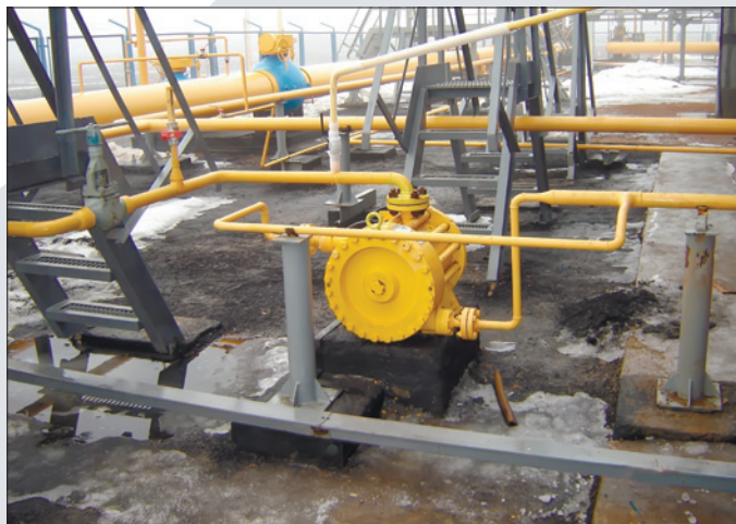
Рис. 1. Утилизирующая детандерная установка на базе вихревой расширительной машины
