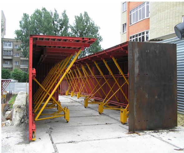
Рис. 3. Туннельная опалубка стен и перекрытий «Утинор».
