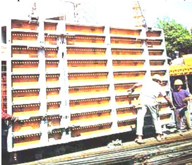
Рис. 2. Крупнощитовая опалубка стен фирмы «Тиссен»
