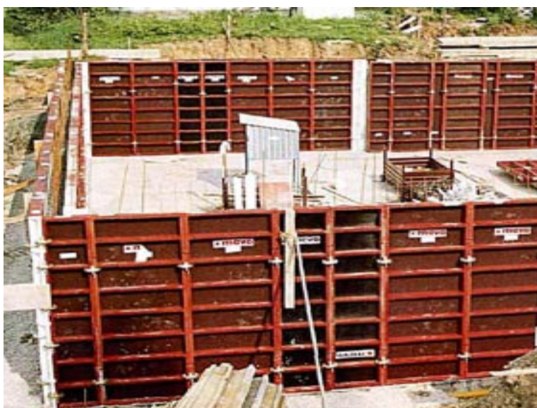
Рис. 1. Возведение стен в опалубке «Стар тек».
