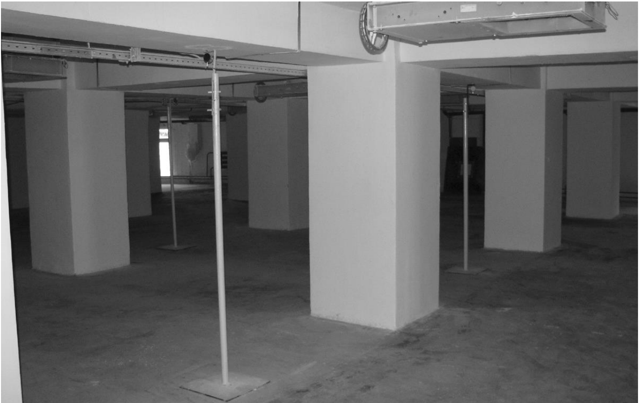
Рис.1. Розміщення стійок із закріпленими індикаторами годинникового типу по центру балок ребристого перекриття силосу
