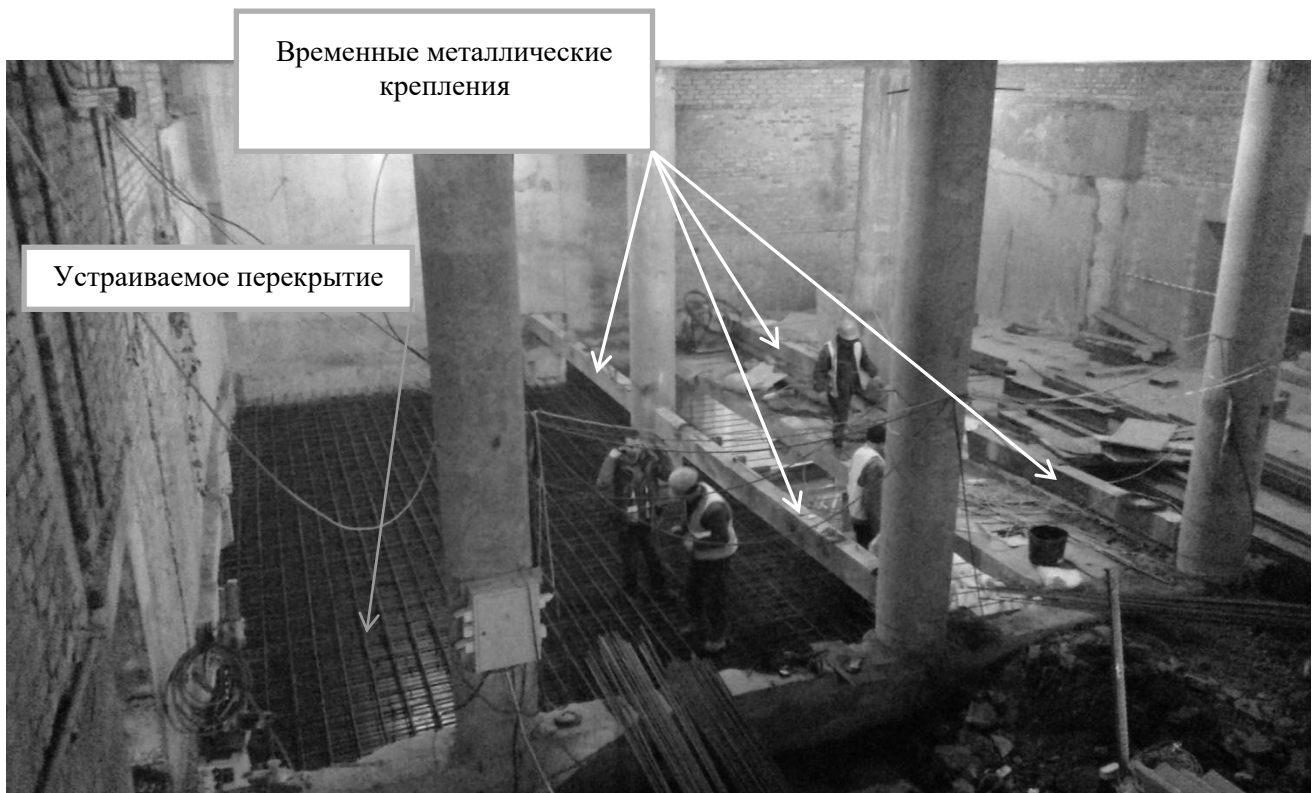
Рис.4. Замена конструкций перекрытия
