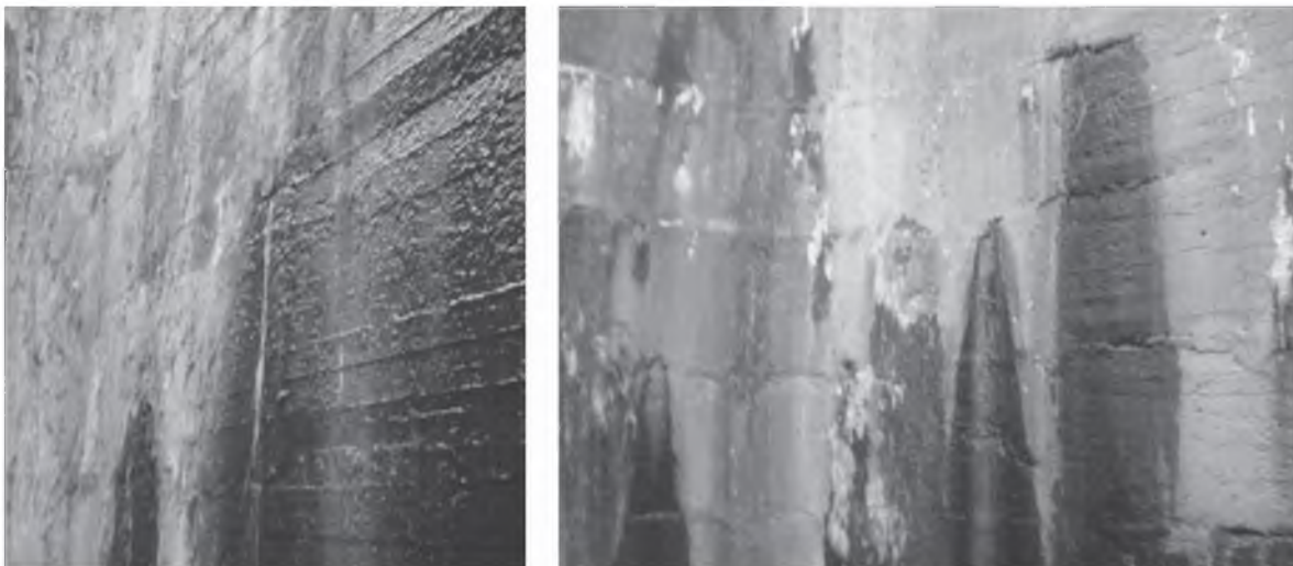
Рис. 1. Місця активних протікань на гідротехнічних спорудах
