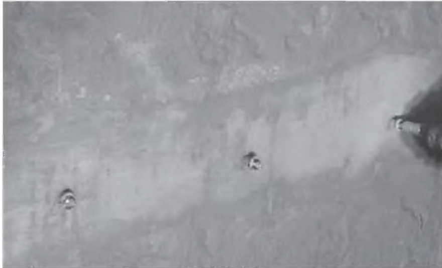
Рис. 4. Ділянка стіни насосної станції, підготовленої до ін'єктування
