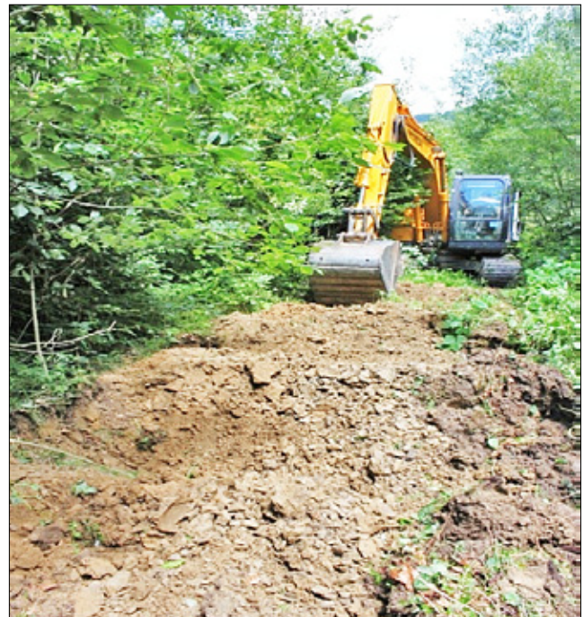
Рис. 1. Процес меліорації трелювального волока гусеничним екскаватором
