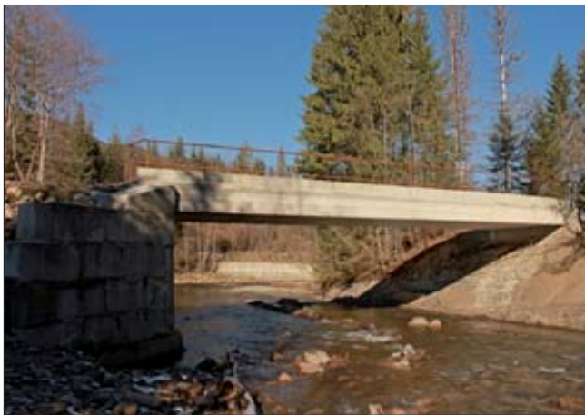
Рис. 3. Міст капітального типу з використанням залізобетонних конструкцій та скальної основи як берегової опори
