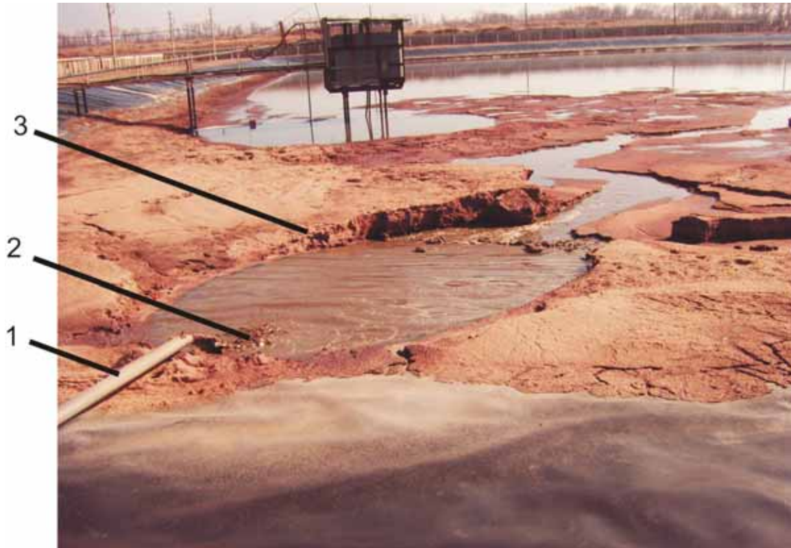
Рис. 3. Фрагмент става - накопичувача рідкої фракції, яка подається з сепаратора BAUER S655.
