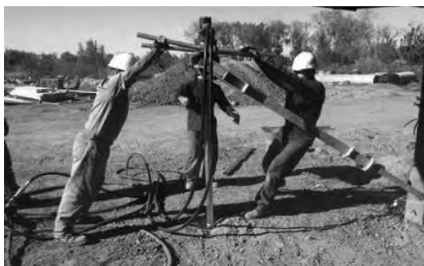
Рис. 1. Завинчивание сваи средствами малой механизации
