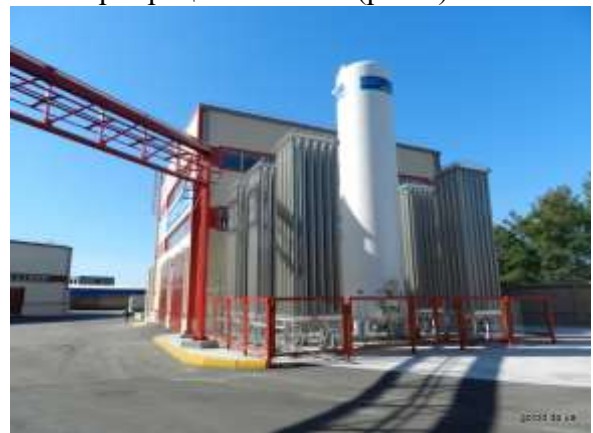
Рис. 3. Завод по переработке аккумуляторов в Днепропетровске
