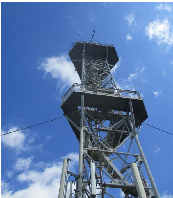
Рис. 2. Металева решітчаста двохярусна вежа з паралельними поясами.
