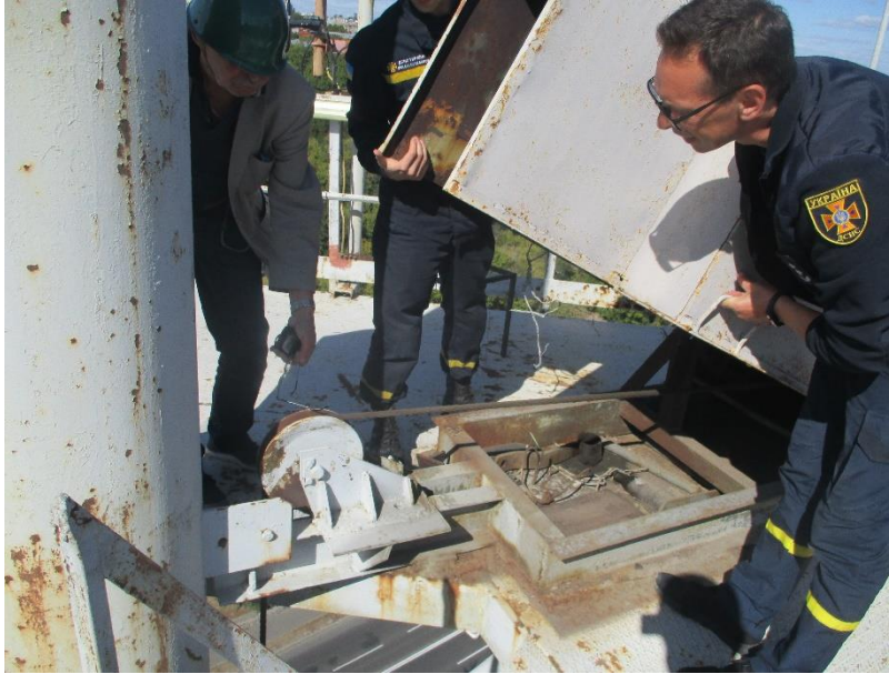
Рис 3. Механізм для підйому щогли на площадці на відм. 25.88м.
