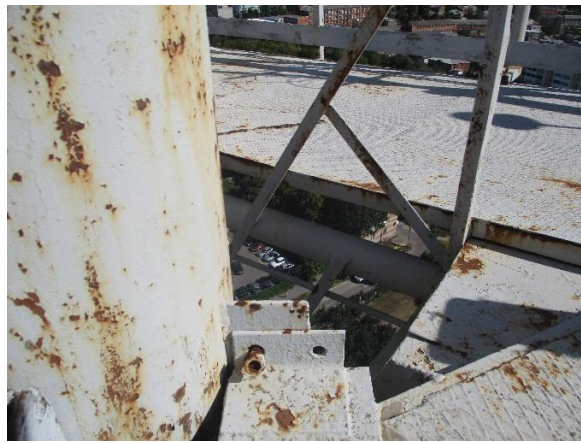
Рис. 5. Фасонка вежі на рівні другого робочого майданчику обрізана, другий болт між фасонкою щогли і кутиком опори встановити неможливо.
