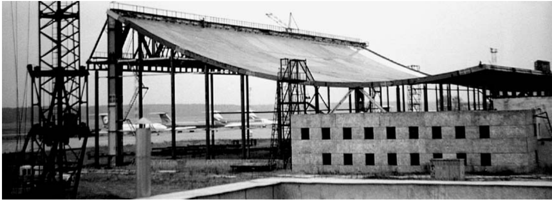
Рис. 1. Ангарный корпус в г. Риге, монтаж мембранного покрытия
