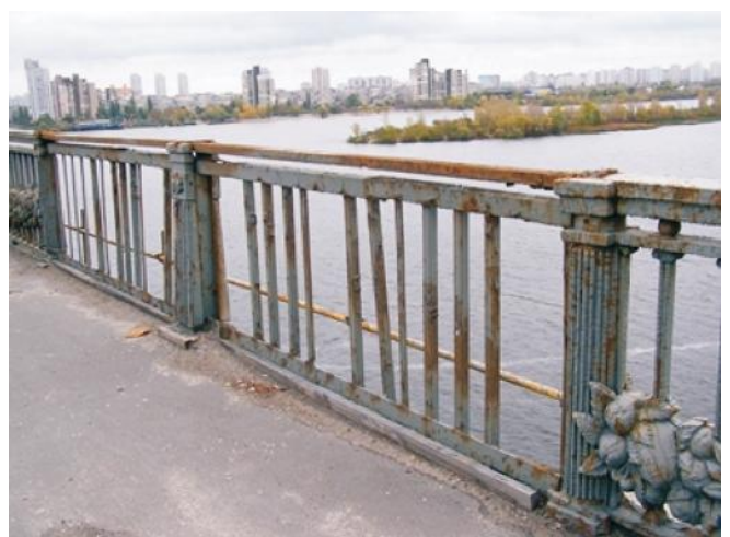
Рис. 10. Руйнування секції поручня та його кріплення, відрив декоративних елементів
