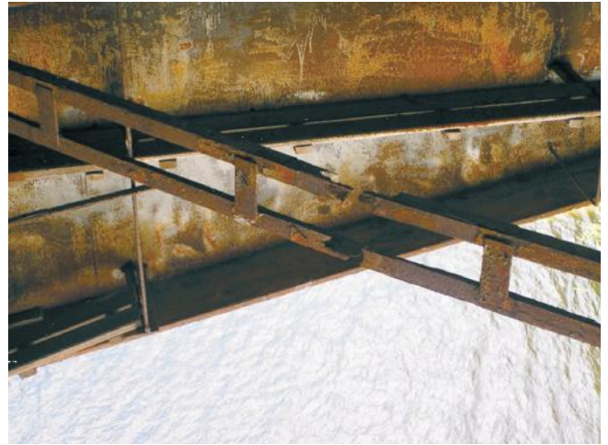
Рис. 6. Розрив в'язі в прогоні 16–17 внаслідок корозії
