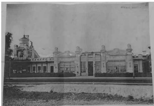
Рис. 2 – Залізничний вокзал станції Голоби. 1903 р. Арх. О. М. Вербицький.
