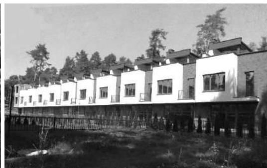
Рис. 5. Брюховичі, забудова новопосталої у лісовому масиві вул. Івана Труша, 2020 (фото Петришин Г.)
