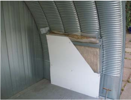
Рис. 15 – Фрагмент безкаркасного арочного ангара
