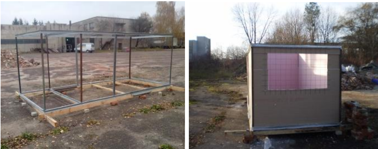
Рис. 1. Конструкція модельного приміщення
