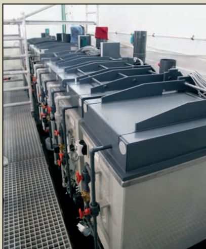
Завершується монтаж гальванічної лінії твердого хрому. Карбувальні штемпелі для виготовлення пам'ятних монет потребують покриття гальванічним способом шаром твердого хрому, який надає їм необхідної твердості й стійкості.
