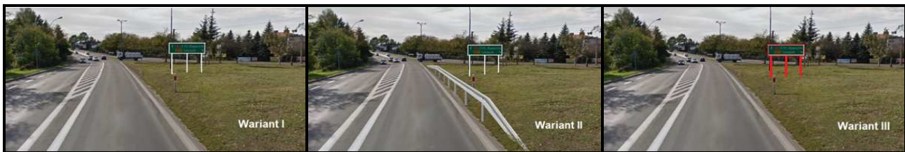
Rysunek 5 - Trzy warianty ustawienia tablicy informacyjnej na poboczu drogi krajowej DK94 w mieście Łańcut
