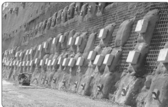
Рис. 6. Анкерування підпірної стінки гвинтовими анкерами
