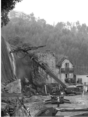
Рис. 8. Бурова установка закріплена на стрілі екскаватора
