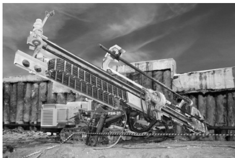
Рис. 7. Установа направлено буріння
