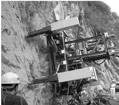
Рис. 9. Бурова установка змонтована на роботі-альпіністі
