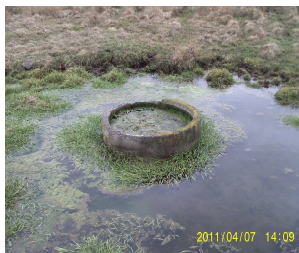
Рис. 1. Види пошкоджень оглядових колодязів: а) колодязі в яких відсутні верхні кільця; б) механічні пошкодження плити перекриття та верхнього кільця; в) засмічення, замулення, засипання колодязя; г) колодязі, які знаходяться в стані відмови
