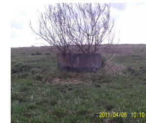
Рис. 1. Види пошкоджень оглядових колодязів: а) колодязі в яких відсутні верхні кільця; б) механічні пошкодження плити перекриття та верхнього кільця; в) засмічення, замулення, засипання колодязя; г) колодязі, які знаходяться в стані відмови
