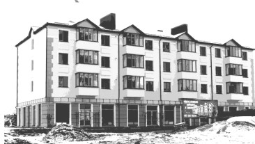
г) Багатоквартирний житловий будинок по вул. Щаслива
