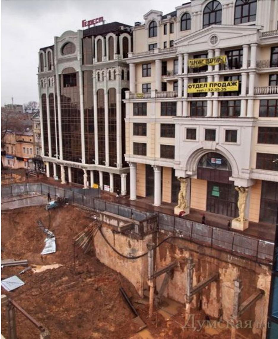
*Рис. 5. Обрушение стенок котлована на Греческой площади в Одессе*
