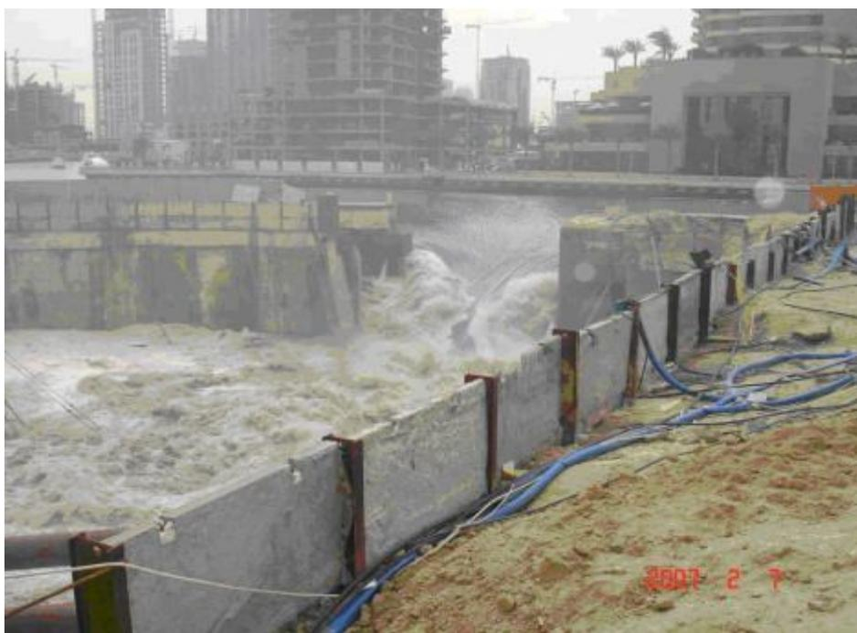
*Рис. 6. Обрушение котлована в Загребе в 2007 г.*
