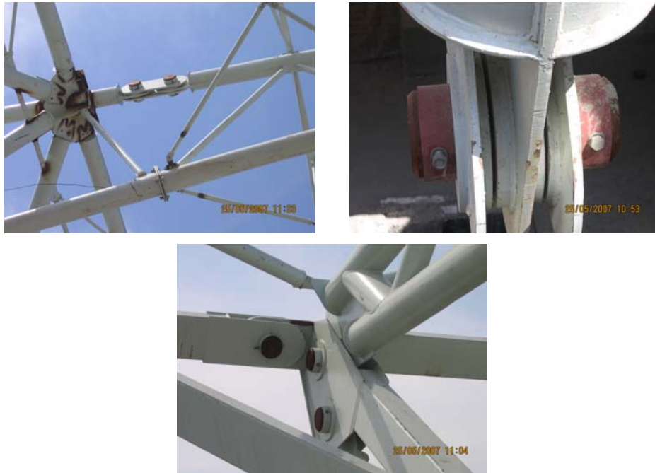
Рис. 1. Конструктивные особенности соединений, вызывающие местную (щелевую, контактную) коррозию
