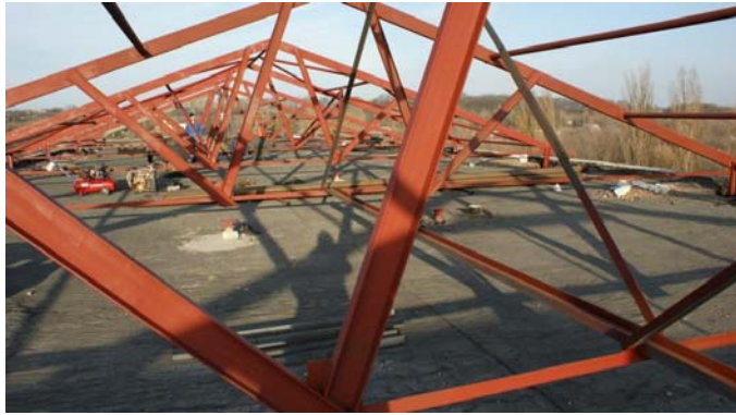
Рис. 4. Конструкції на монтажній позначці
