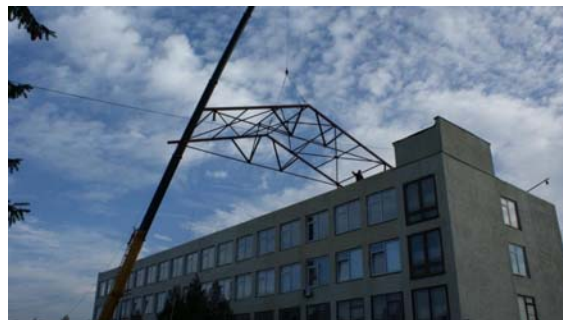
Рис. 3. Подавання блоку на монтаж
