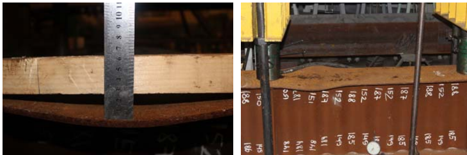
Рис. 4. Випинання верхнього поясу балки Б3
