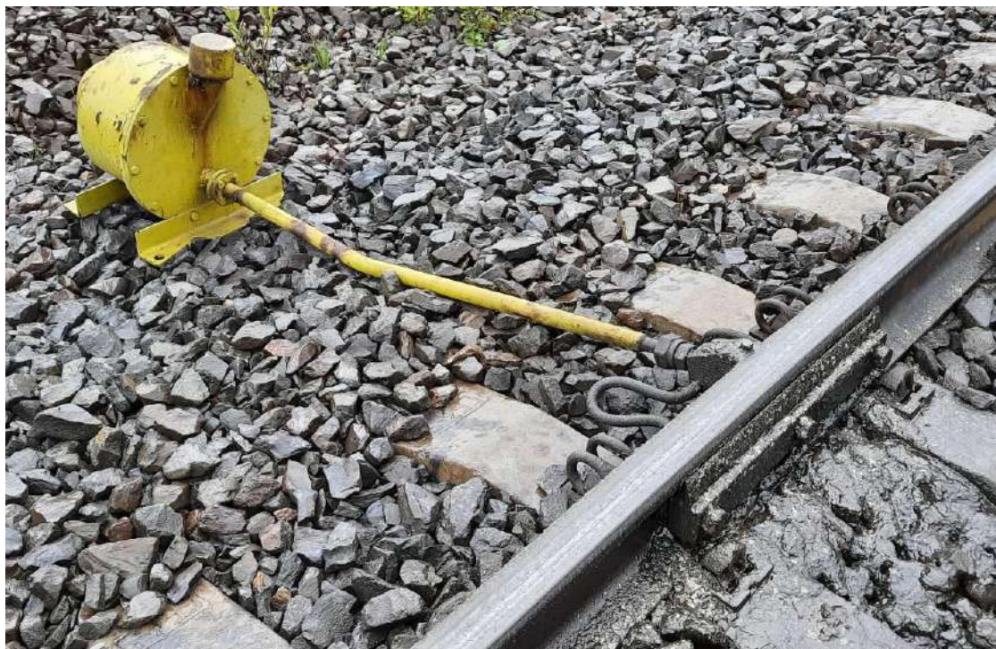
Рис. 2 – Стационарний рейкозмащувач проекту 1901.000.СБ
