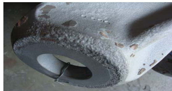
Рис. 3. Корозійне ураження торцьової поверхні вузла-п’ятки підкоса підредукторної рами. Джерело: [6, с. 15].
