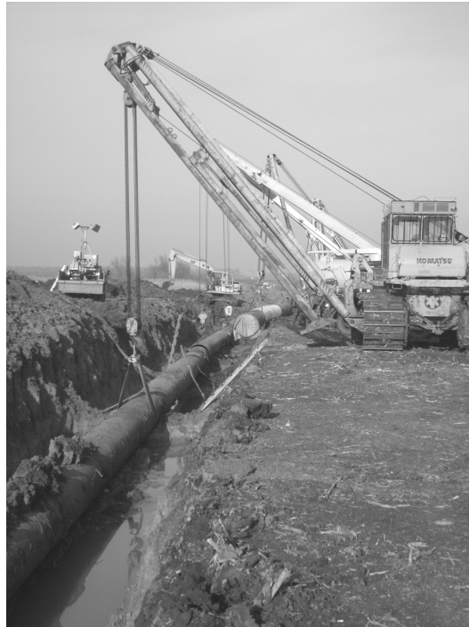
Рисунок 3 – Процес поєднання нової та існуючої ділянок нафтопроводу
