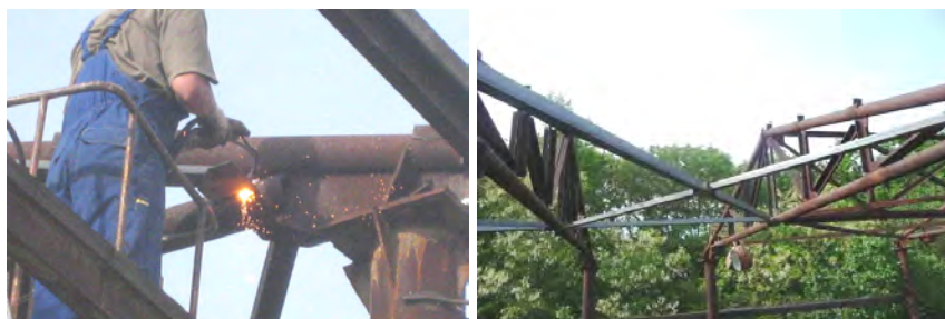
Рисунок 3 – Монтаж в'язей по нижньому поясу ферм
