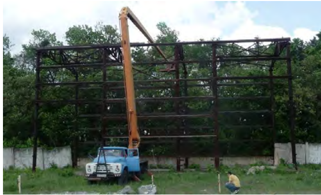
Рисунок 1 – Загальний вигляд каркаса
