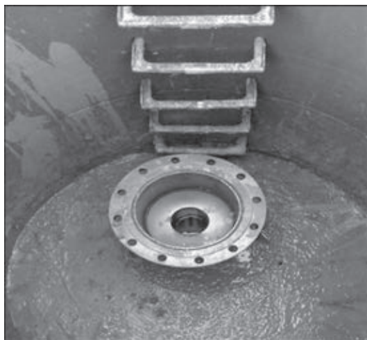
Рис. 1. Горловина трубы теплообменника и наружные условия выполнения работ
